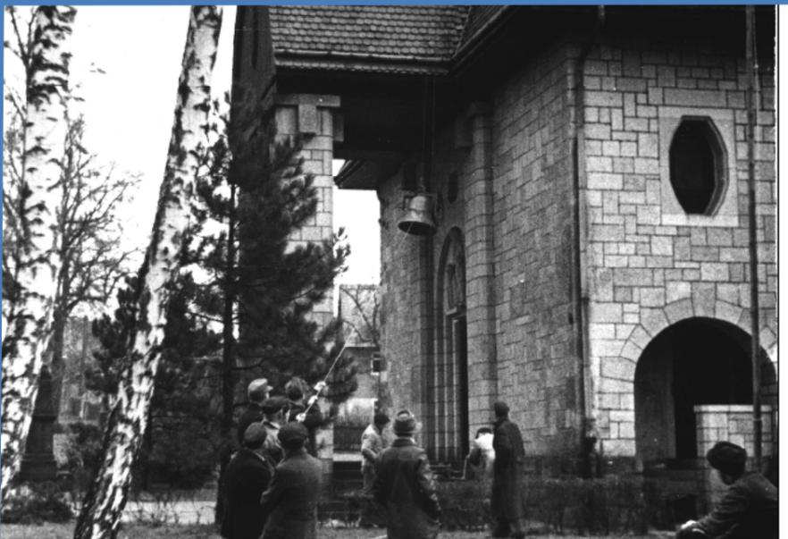
Die Fotos zeigen das Einheben der neuen Stahlglocken 1956 in Handarbeit. Diesmal wird ein Kran die Arbeit übernehmen
